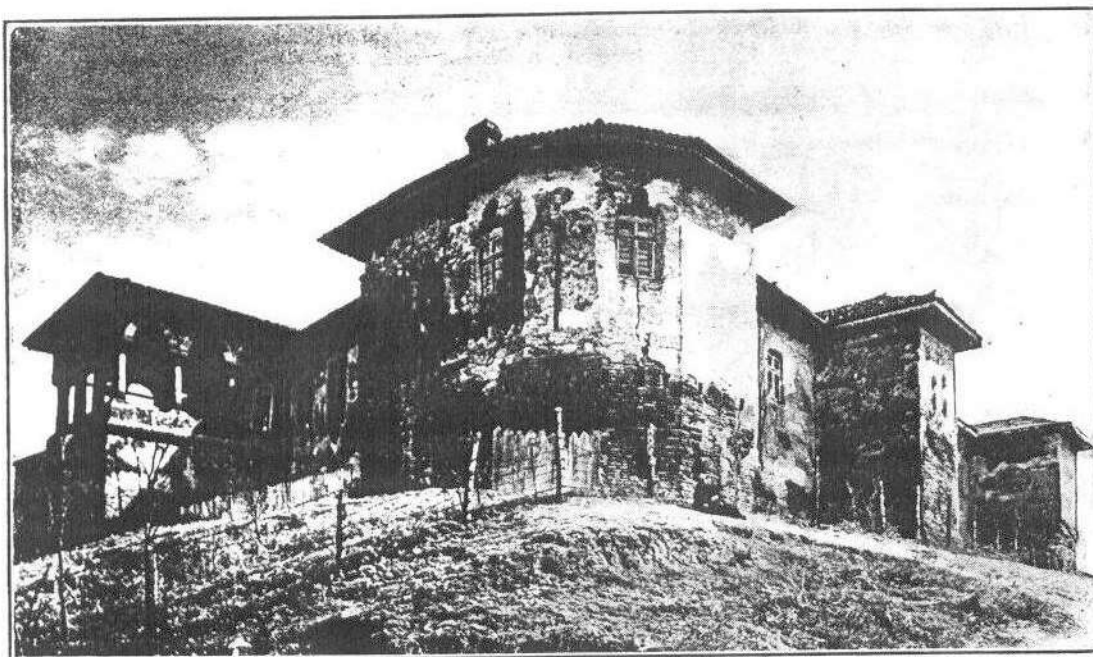
Fig. 95. Mănăstirea Comana văzută dinspre Nord-Vest.
