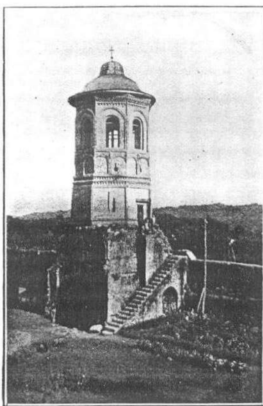
Fig. III. Turnul-clopotniță de la Brebu văzut din curte.
