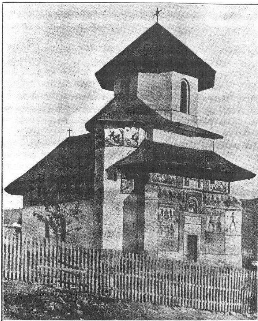
Fig. 121. Biserica din Bărbuleț-Dâmbovița.
